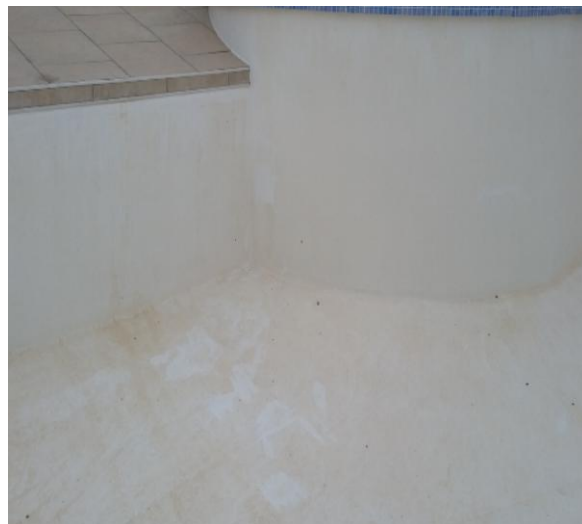
Dépôts clairs ou zones ternies : rechercher calcaire, vieillissement ou déséquilibre.
